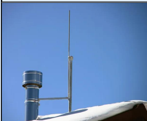
Металлический штырь. Как правило, это стальной металлический стержень длиной от 0,5 до 4 м и диаметром 10-12 мм.
