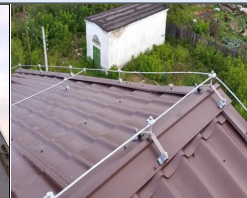
Сетчатый молниеприемник. Несколько молниеприемников устанавливают в уязвимых частях кровли и соединяют друг с другом
